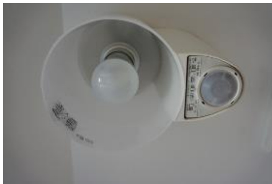
センサーとライトが一緒になっているタイプの例
