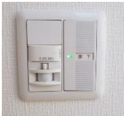
センサーとライトが別々のタイプの例 (センサー側)
